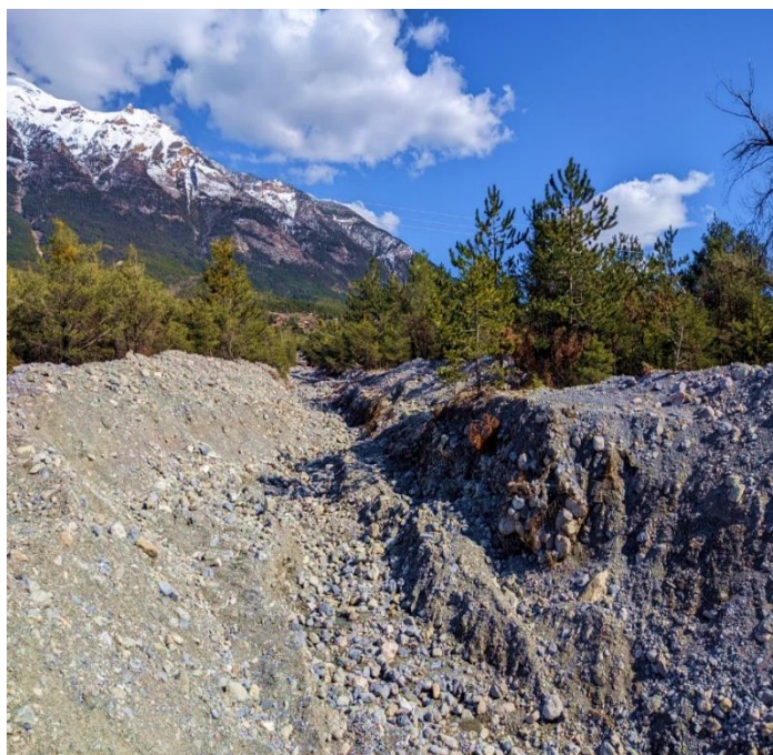
Figure 3 - Lit du Merdanel depuis le pont sur la RN 94, en regardant en direction du passage à gué "aval"
