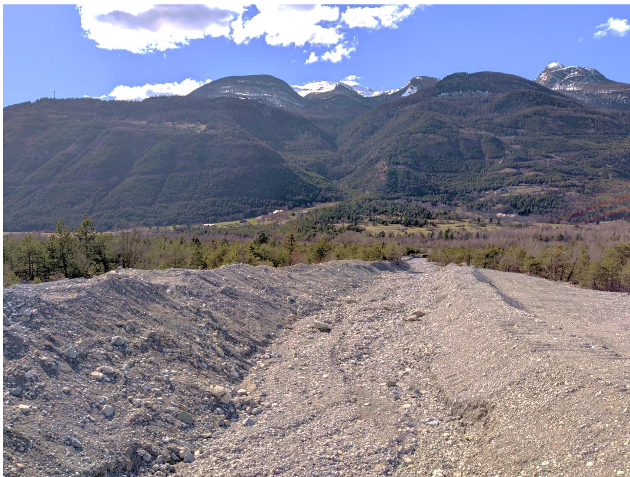
Figure 11 – Lit du Merdanel, vu depuis le pont de la RN 94, en regardant en direction du pont SNCF et de la Durance
