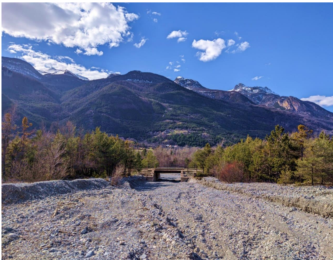
Figure 5 - Dans le lit du Merdanel, en assec, face au pont SNCF et en regardant en direction de la Durance
